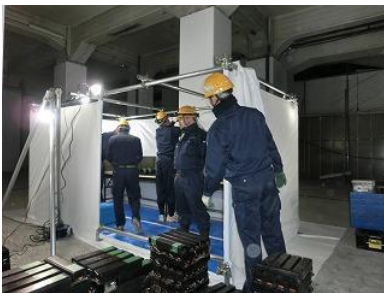
(作業場組立作業)
