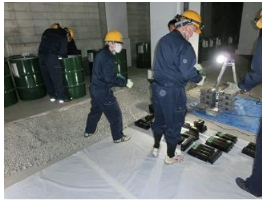
(安定器取出し仕分け作業)
