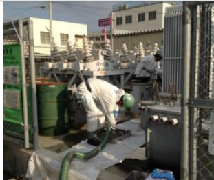
(トランスの抜油作業)
